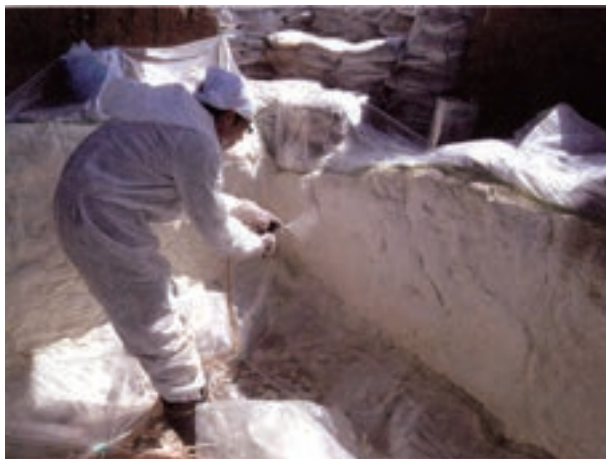
図 500 玄室発泡ウレタン吹付状況
