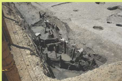
土留された溝
