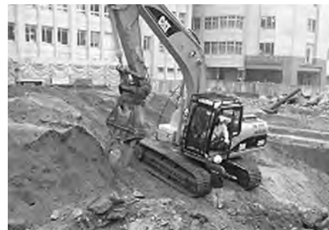
既設プールの解体状況
