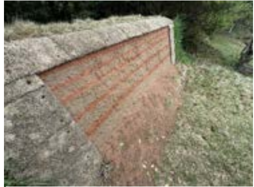
版築ミニチュアモデル (設置場所：大野城跡)
