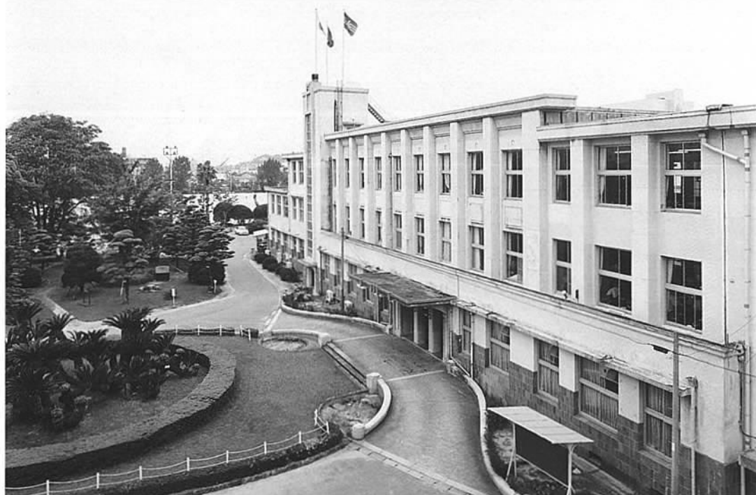
2 修猷館高校校舎本館 (調査前、南東から)
