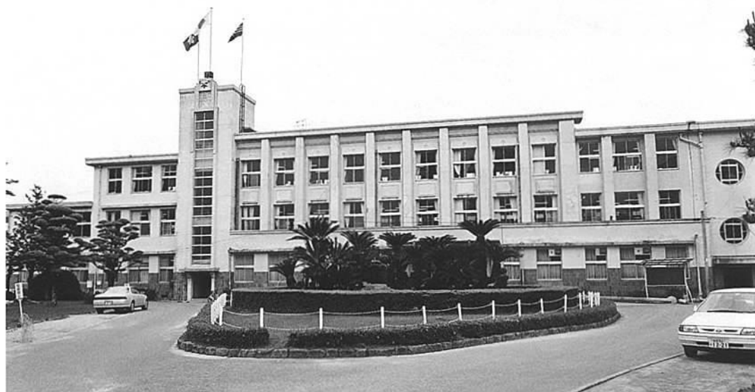
1 修猷館高校校舎 (調査前、南から)
