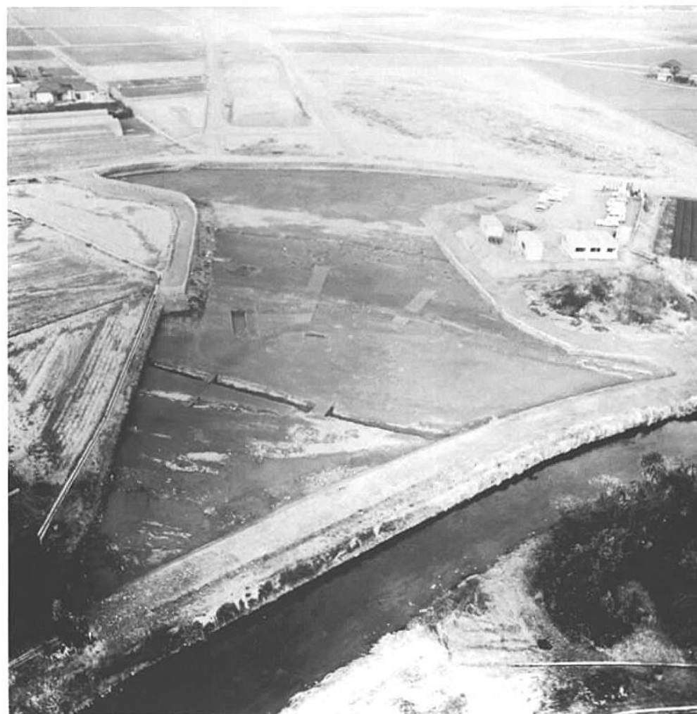
2 I区第一遺構面東部分全景（東から）
