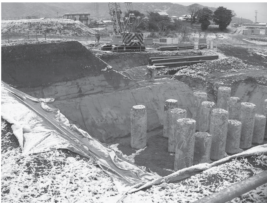
工事が進む延永ヤヨミ園付近 (壁面の土層は阿蘇4)
