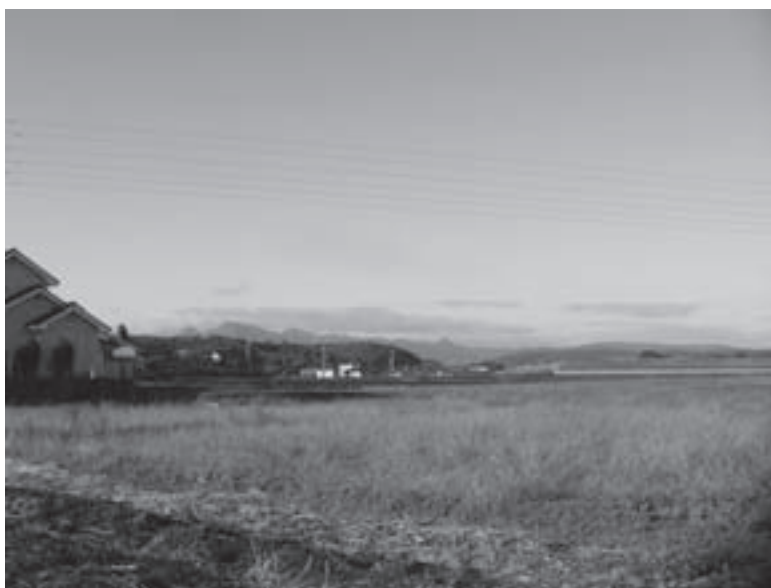
工事の進む龍毛遺跡の向こうに豊前の山岳地帯を見る
