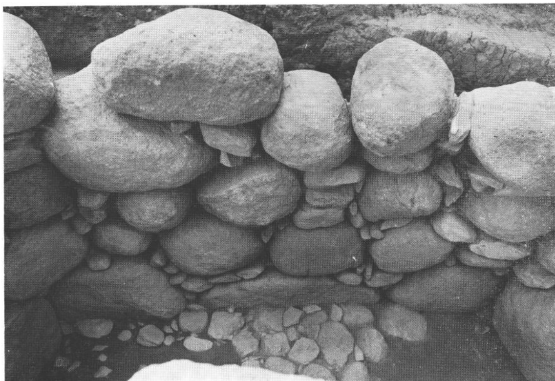
同後室右側壁石積状態
