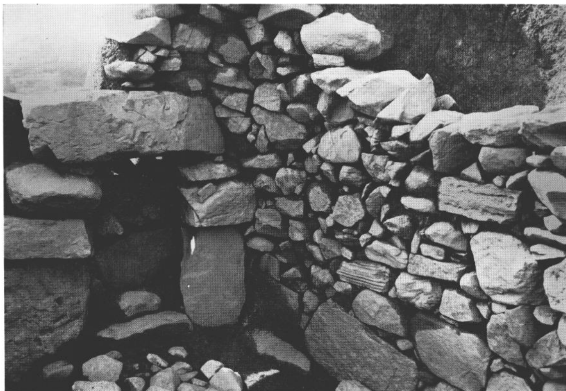
汐井掛16号墳左側壁石積および玄門閉塞状態
