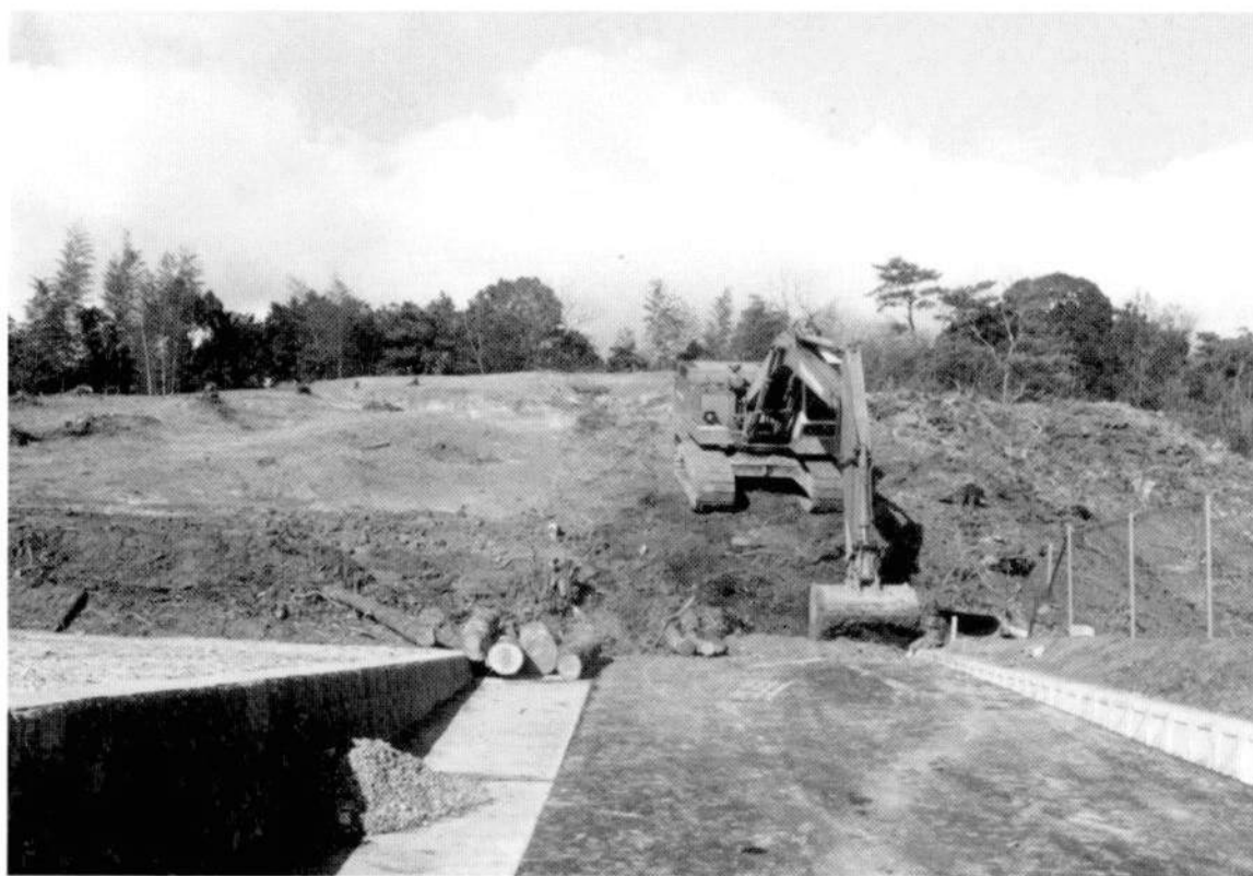
2. トヲノ尾遺跡発掘区表土剥ぎ風景（南から）
