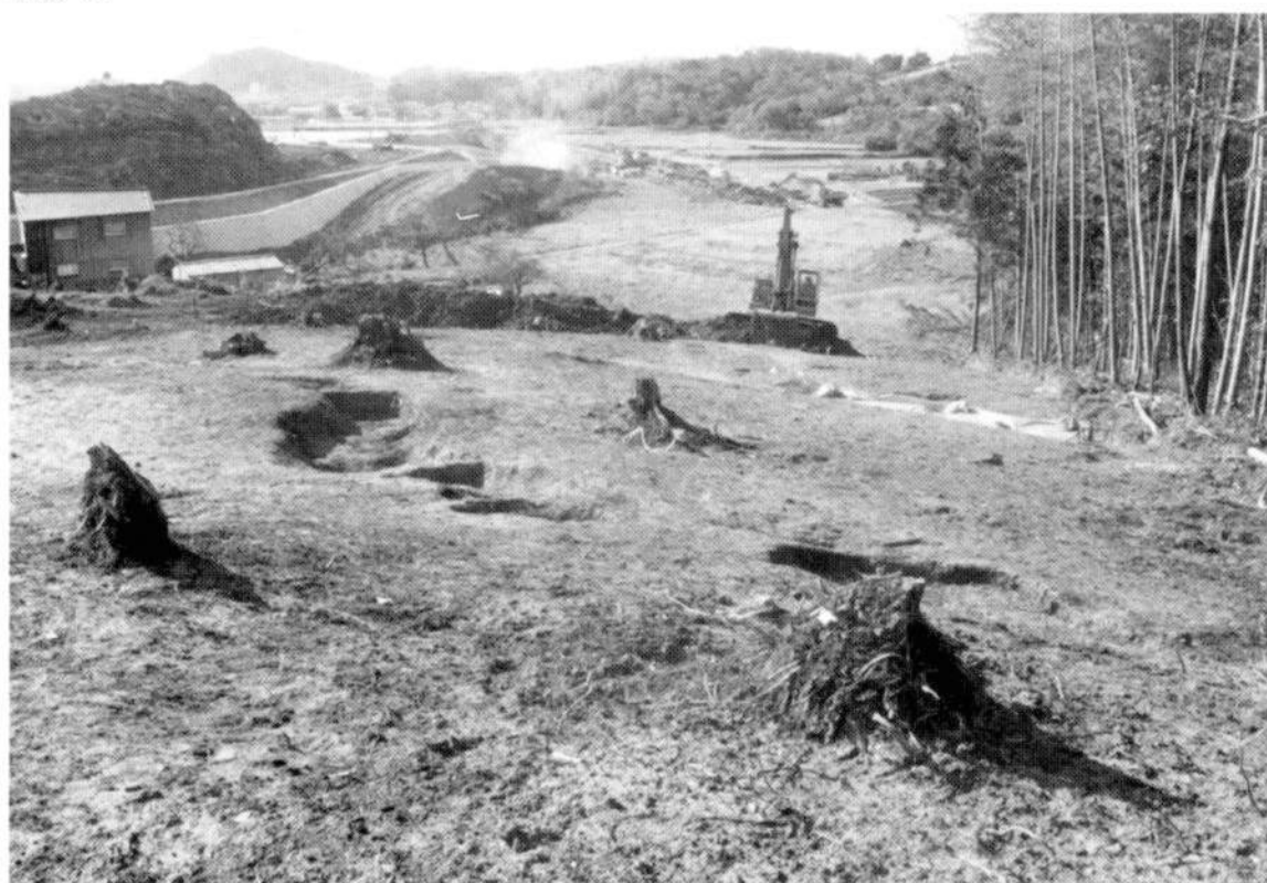
1. トヲノ尾遺跡発掘区表土剥ぎ風景（東から）
