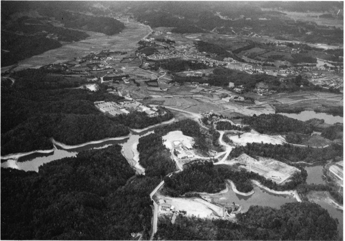
(1) 彼岸原丘陵俯瞰写真（南東から）
