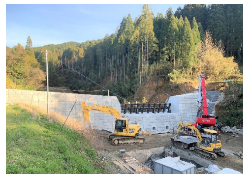
砂防ダムも完成間近
