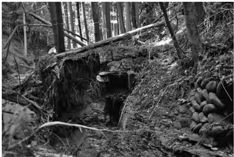
3 堰の取水口（上流から）
