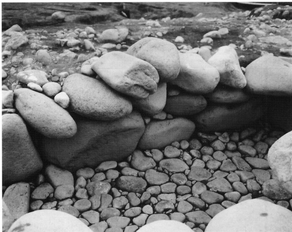
1 12号墳石室左側壁状況（南から）
