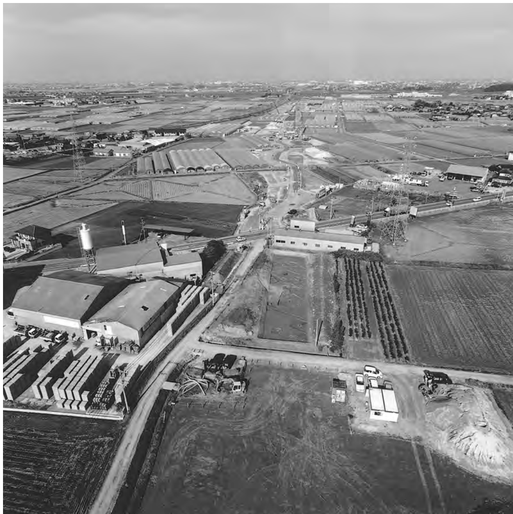
7区第一遺構面全景 (南から)
