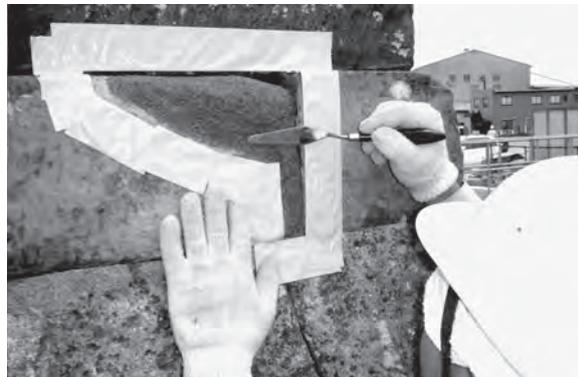
7. 石材修理 (擬石による補強修理)
