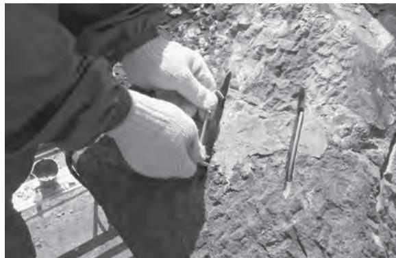
8. 石材修理 (アンカーによる笠割裂部修理)
