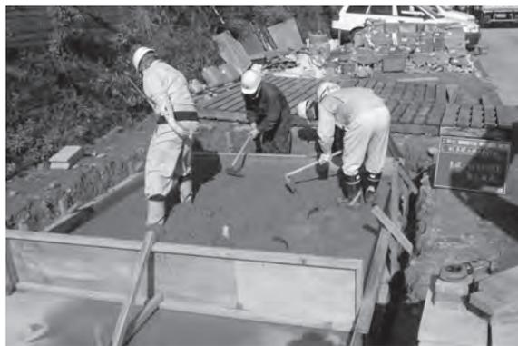
高さ調整のためコンクリート打設
