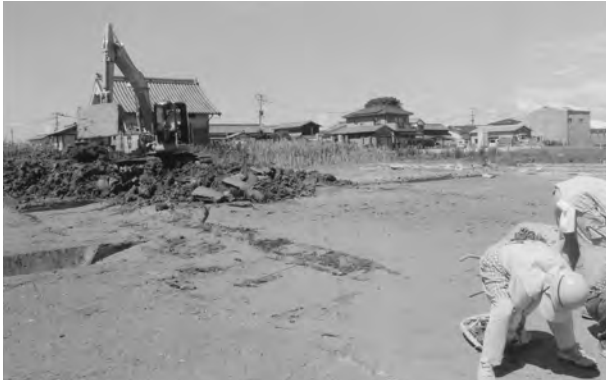
II 区の重機掘削および検出状況
