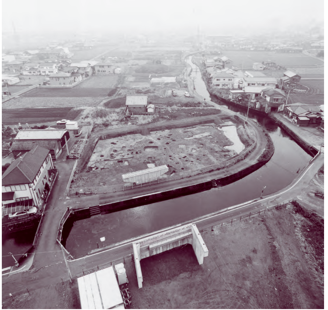
1. I b区 遠景 (北から)
