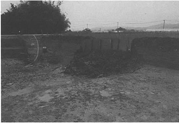
7号溝東壁崩壊状況（北西から）
