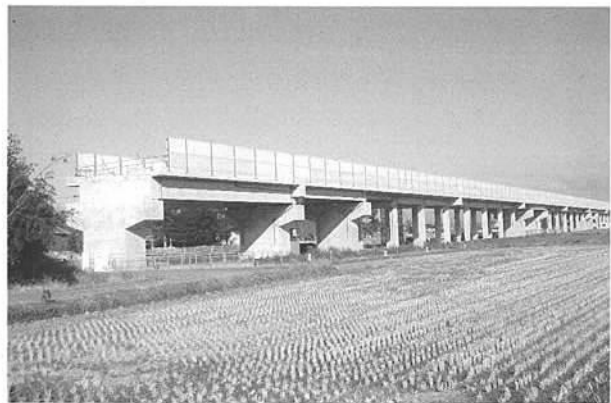
遺跡周辺新幹線高架工事状況
