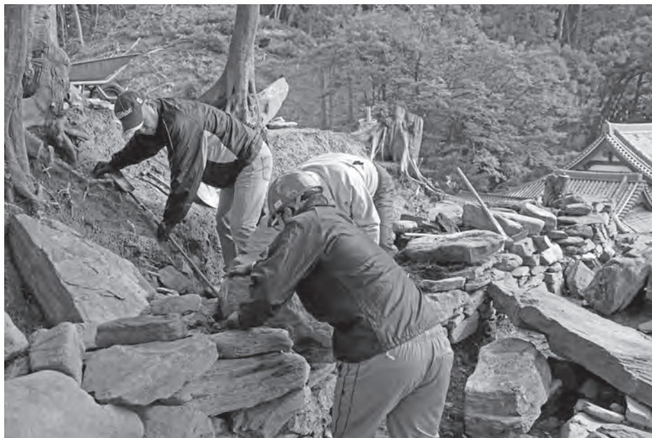
積石遺構中の墓碑確認作業（左奥は南淋寺住職）
