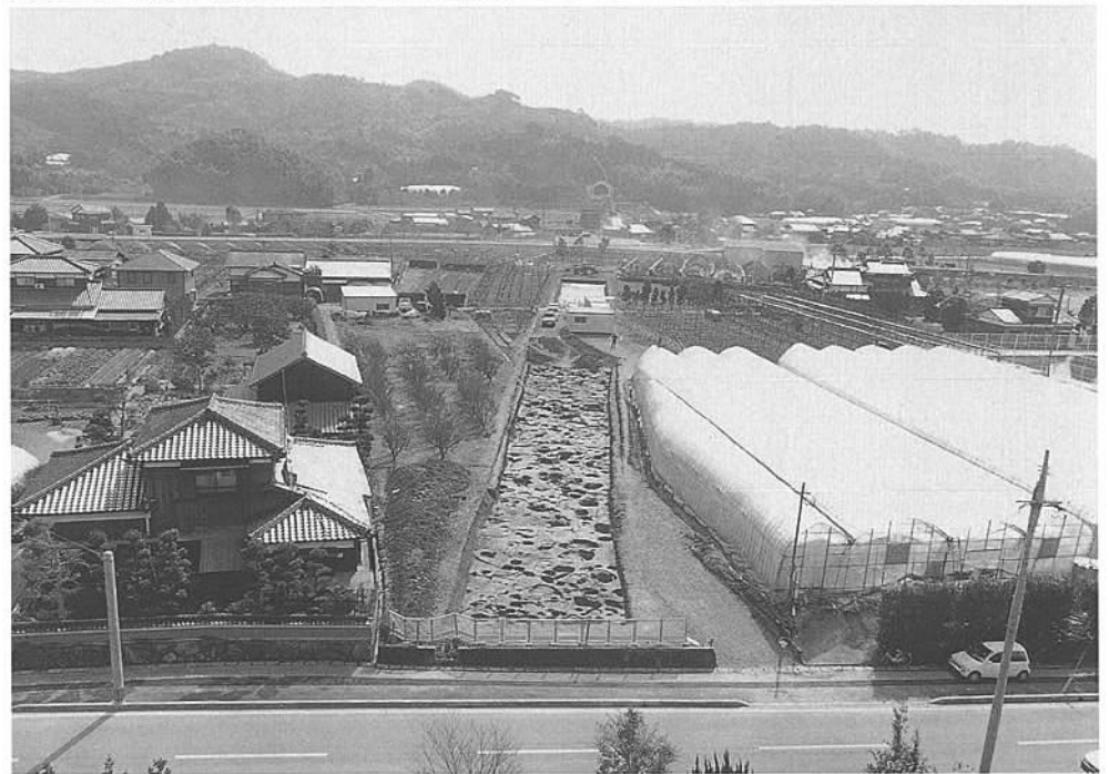
2. 第2次調査区北半 空中写真（北から）
