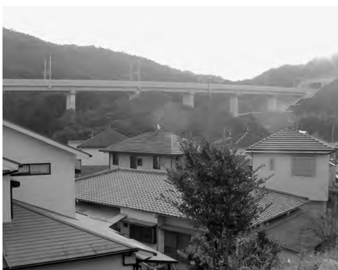
建設中の九州新幹線
