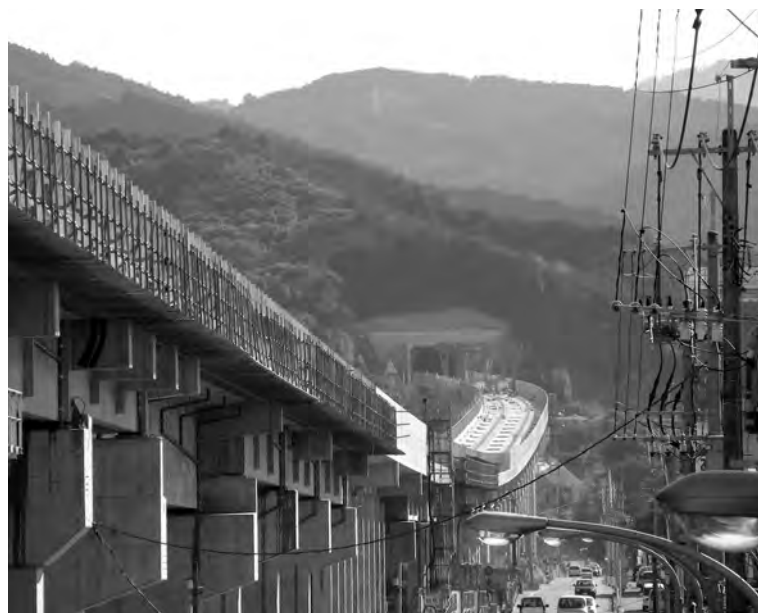
博多南駅から工事中の高架橋を見る。坑口は梶原トンネル。
