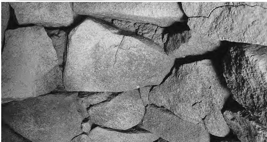
4.同石材間の粘土充填 状況（南から）
