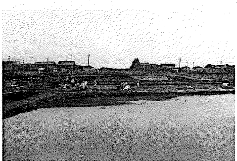
第8図 水没する遺跡の復旧作業
