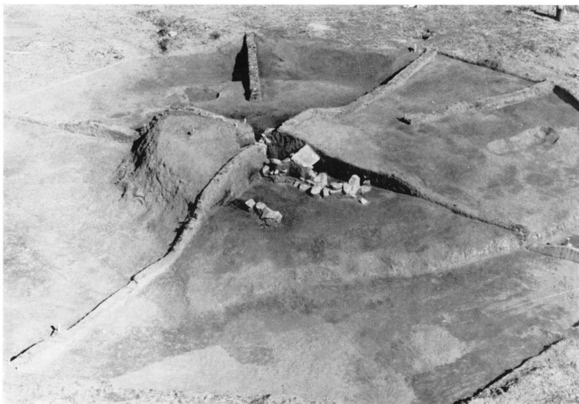
1 一部墳丘除去後の航空写真
