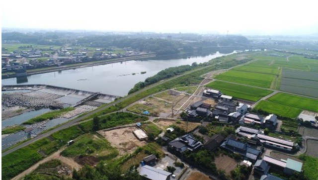
山国川と調査現場
