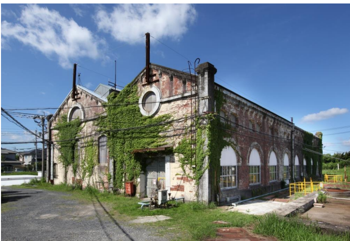
遠賀川水源地ポンプ室 ※非公開施設 （新日鐵住金（株）八幡製鐵所提供）
