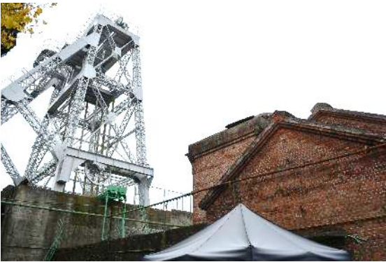
荒尾市にまたがる万田坑の建物とやぐら
