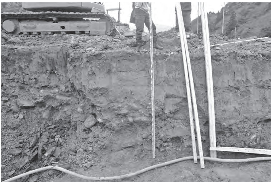
3. 基本土層（工事掘削箇所）
