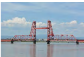
筑後川昇開橋
