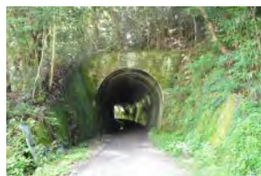
長野トンネル
