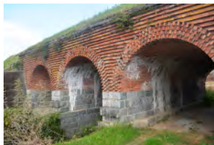
内田三連橋梁の西側(西側)
