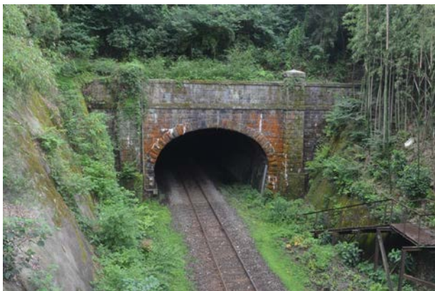
複線断面で建設されたことがわかる金辺トンネル (日田彦山線呼野～採銅所)
