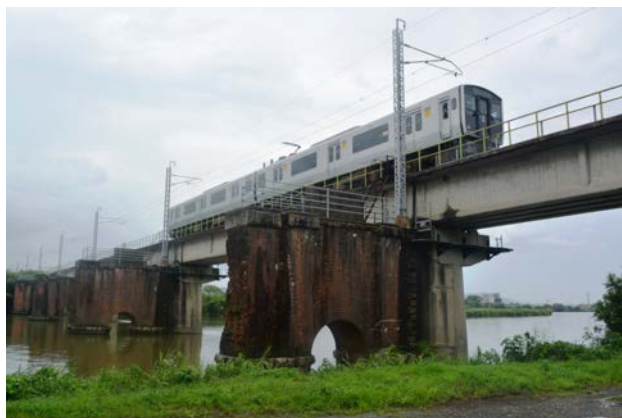
レンガ造の大規模な橋脚が残る遠賀川橋梁 (筑豊本線中間～筑前垣生)
