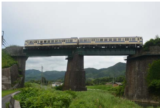
石積みの大規模な橋脚を持つ第二金辺川橋梁 (日田彦山線採銅所～香春)
